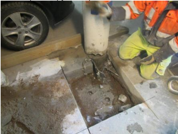
Kuva 16. Lattialaatta ja antura ovat avauksessa hyväkuntoisia.
