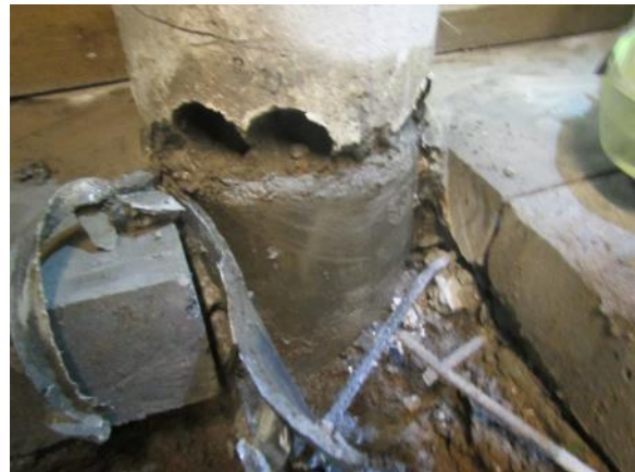
Kuva 17. Lattialaatan tasolla pilarin betoni on rapautumaton ja hyväkuntoinen.
