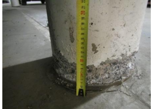
Kuva 21. Pilarin juuressa on rapautumista.
