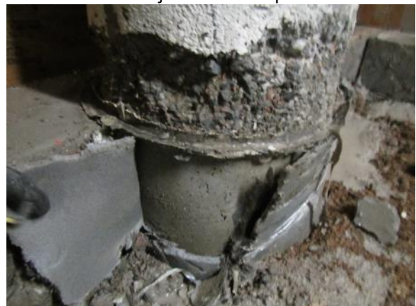
Kuva 23. Lattialaatan alapuolella pilarissa ei ole rapautumista.
