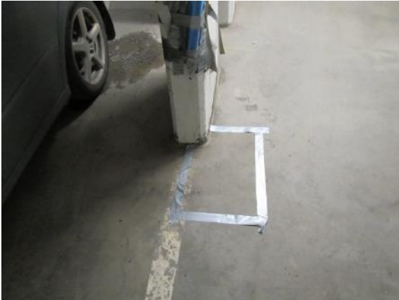
Kuva 8. Tutkimuskohta 2. on seinämäisen pilarin vieressä.
