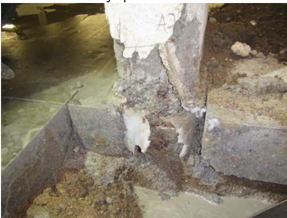
Kuva 12. Pilarin rapautumat / huono tiivistyminen ulottuvat miltei anturaan saakka.
