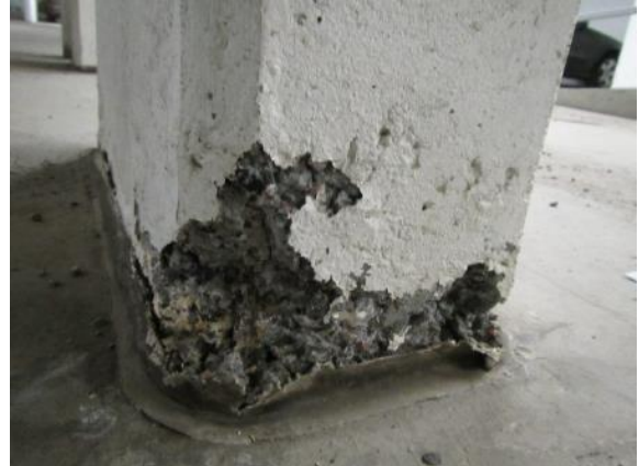
Kuva 3. Pilarin juuren rapautumista.
