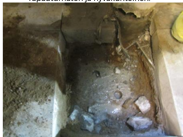
Kuva 19. Anturan yläpinnasta otettiin kaksi poranäytettä.
