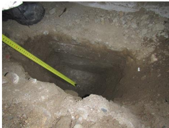
Kuva 29. Anturassa ei vaurioita eikä irtovettä havaittu.
