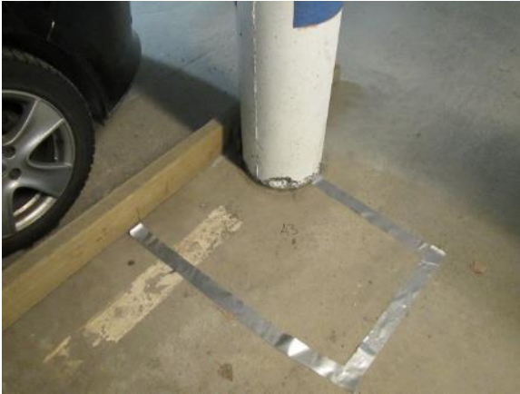
Kuva 14. Tutkimuskohta 3 on ajoluiskan alapäässä pyöreän pilarin vieressä.
