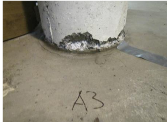
Kuva 15. Pyöreän pilarin alaosassa on rapautumista noin 50 mm:n korkeudelle.
