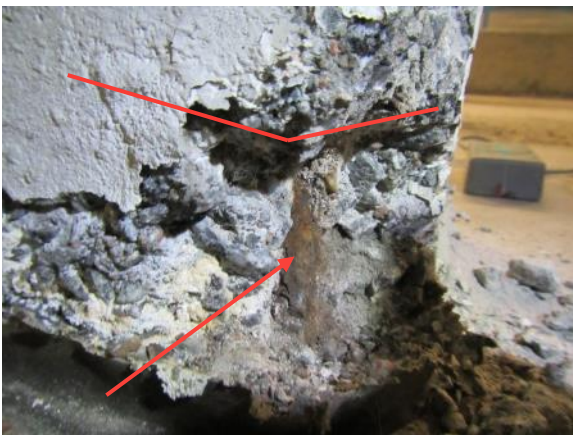
Kuva 6. Haka- ja pääraudoitus on näkyvissä.
