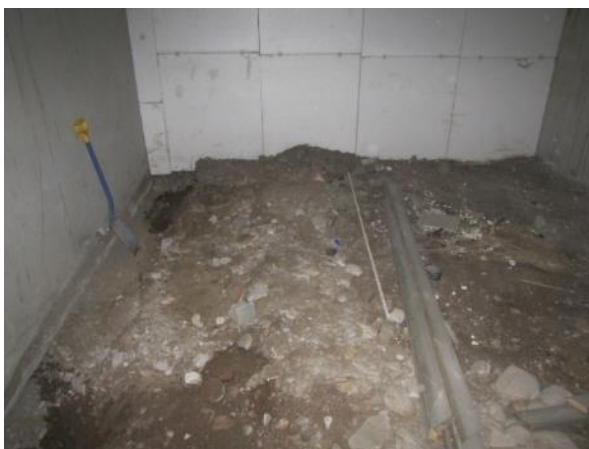
Kuva 28. Hallin viereisen maatyötilan kaivu.
