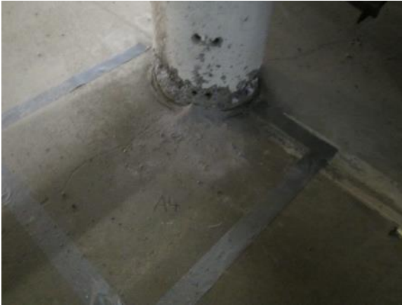
Kuva 20. Yleiskuva pilarista ja avauskohdasta.
