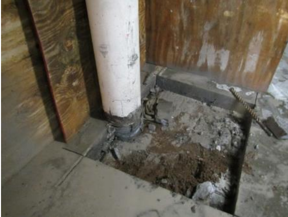
Kuva 22. Avattu lattialaatta ja hiekkatäyttö.
